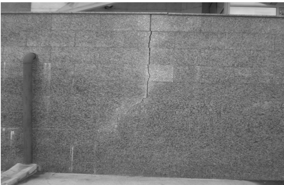
Рис. П2.5. Осадочная трещина со стороны набережной р. Миасс
