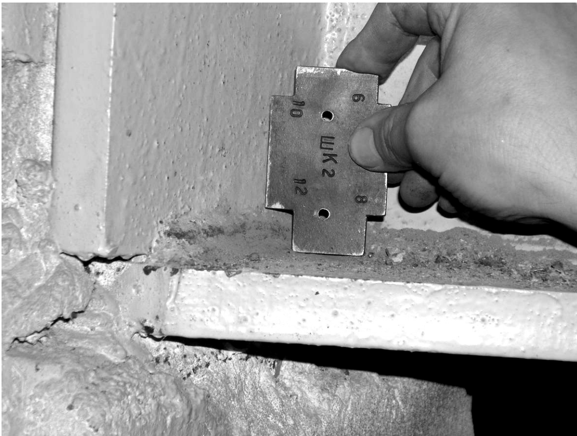
Рис. П2.10. Узел опирания верхнего пояса фермы на колонну. Занижен проектный размер катета углового шва
