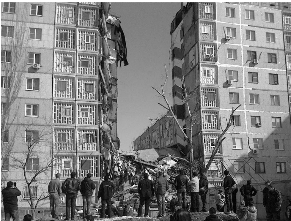
Рис. 1. Момент лавинообразного обрушения секции 9-этажного крупнопанельного жилого дома в г. Астрахани
