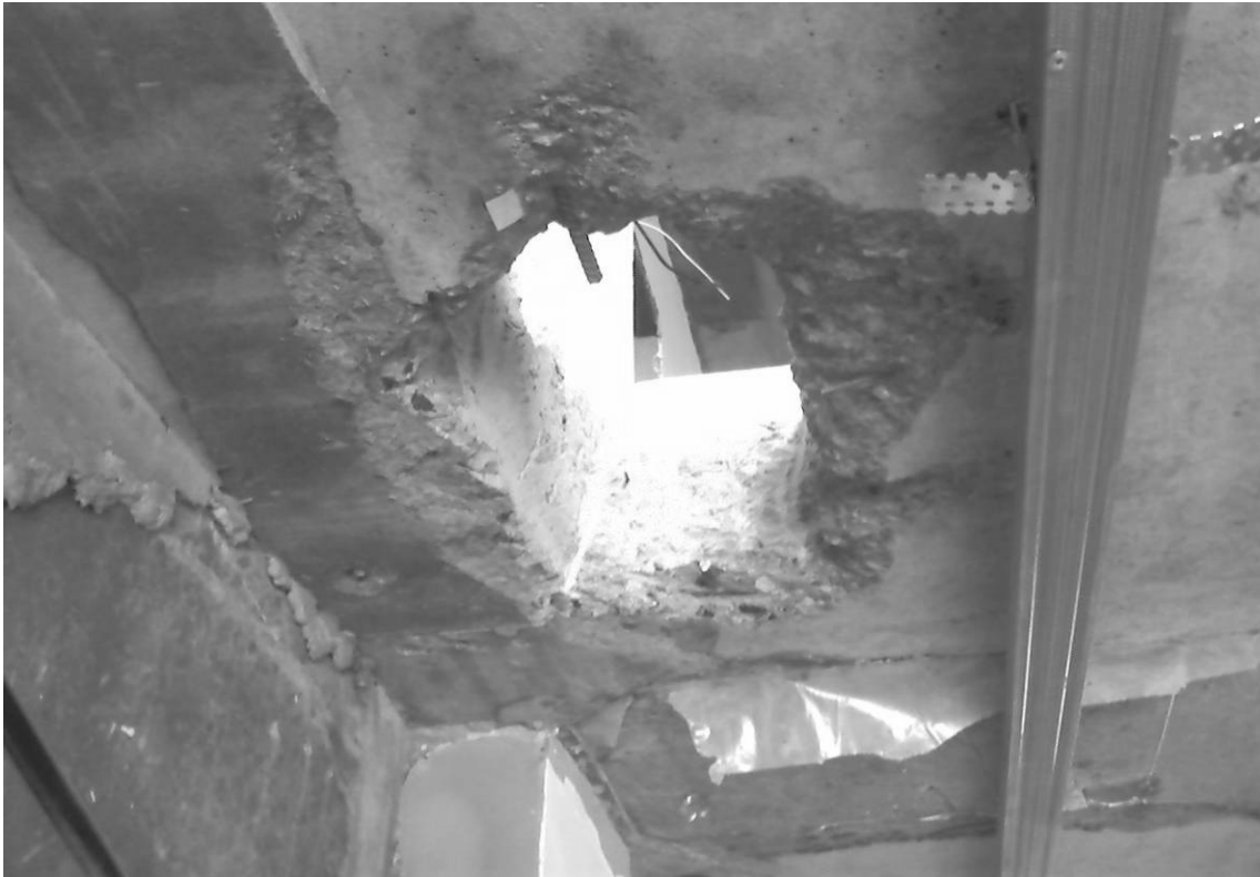
Рис. П2.8. Рубленое отверстие в плите рядом с монолитным ригелем с обрезкой арматуры в ребре
