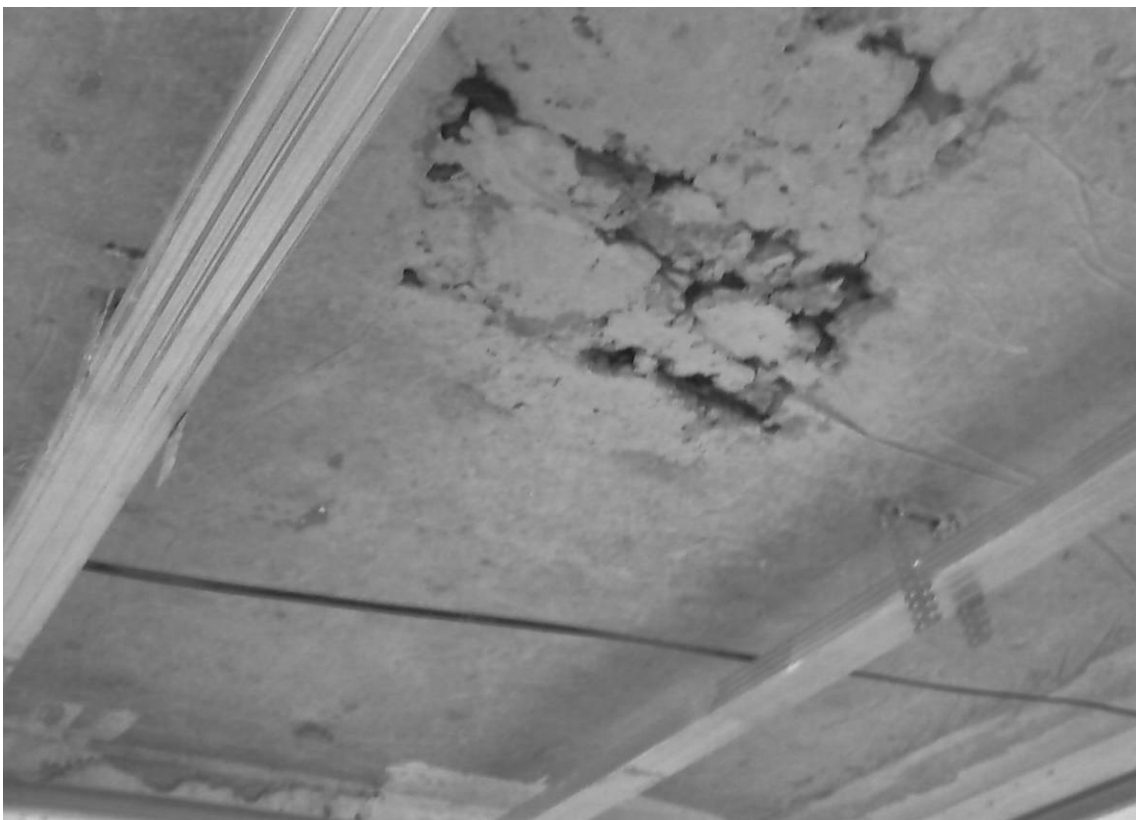
Рис. П2.9. Непровибрированные монолитный ригель с оголением и коррозией рабочей арматуры
