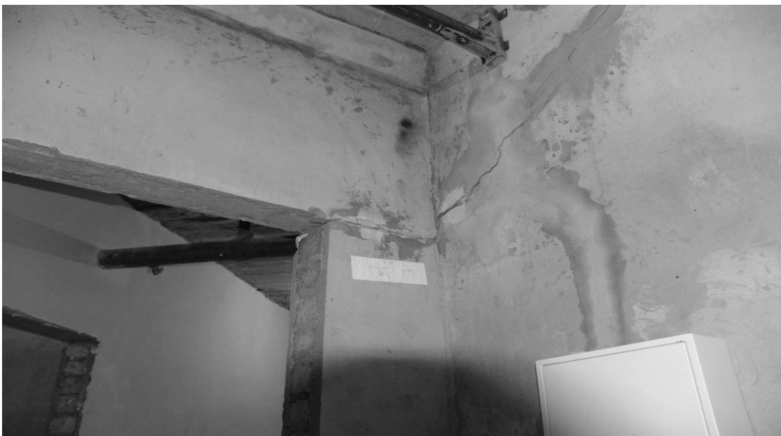
Рис. П2.2. Деформационно-осадочная трещина в сопряжении перегородок цокольного этажа
