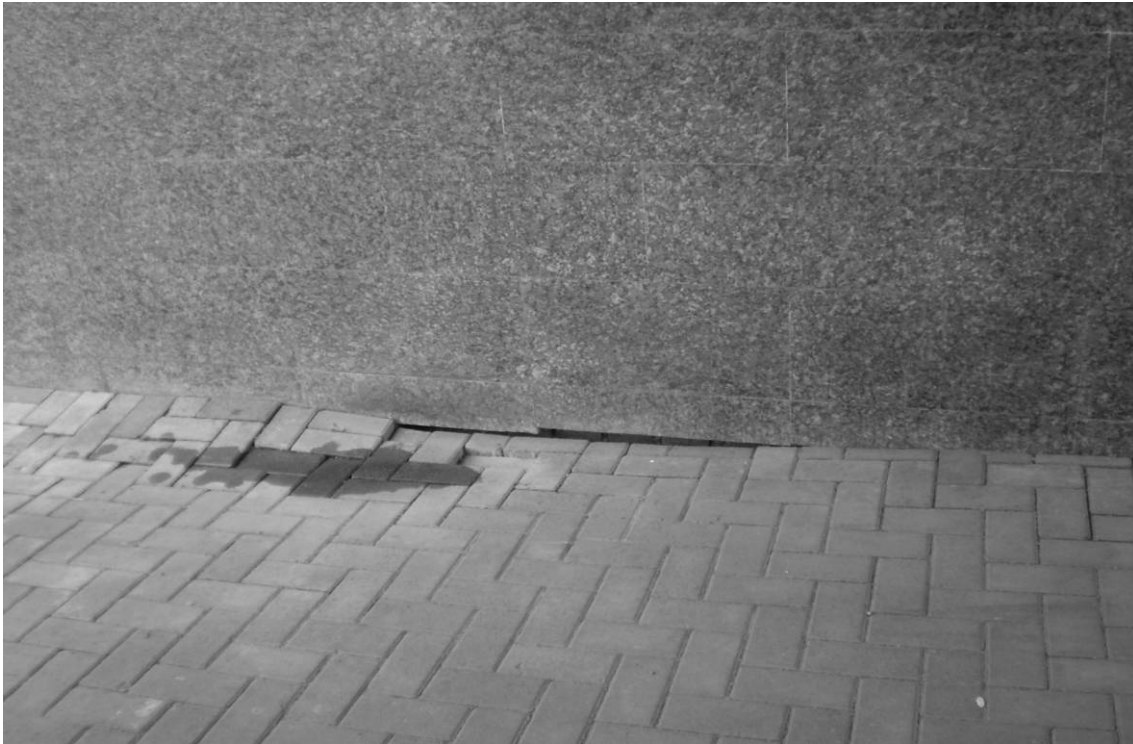
Рис. П2.6. Просадка отмостки здания
