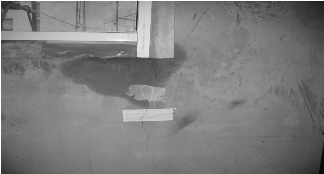
Рис. П2.1. Трещина в наружной стене первого этажа от нижнего угла оконного проема
