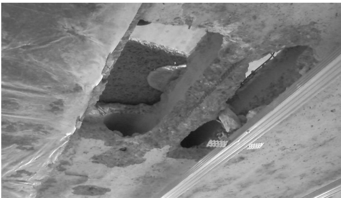
Рис. П2.7. Рубленные отверстия в плите перекрытия с нарушением целостности ребра и оголением арматуры
